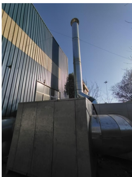
调漆喷漆晾干工序二级活性炭吸附
